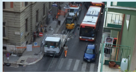
Bari, lavori in via dei Mille: lo slalom degli autobus e il traffico va in tilt
