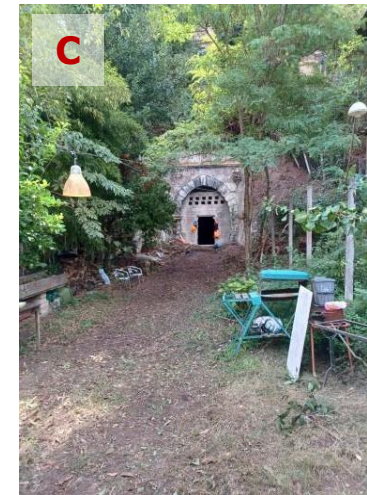
Area tra viadotto e galleria
