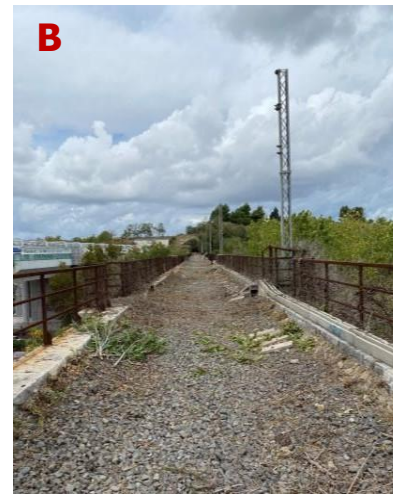
Viadotto ferroviario dismesso
